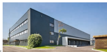
> Location d'un bâtiment de 6 700 m 2 pour le compte de Valor, à Bobigny (93) : un exemple de transaction bouclée par JLL
