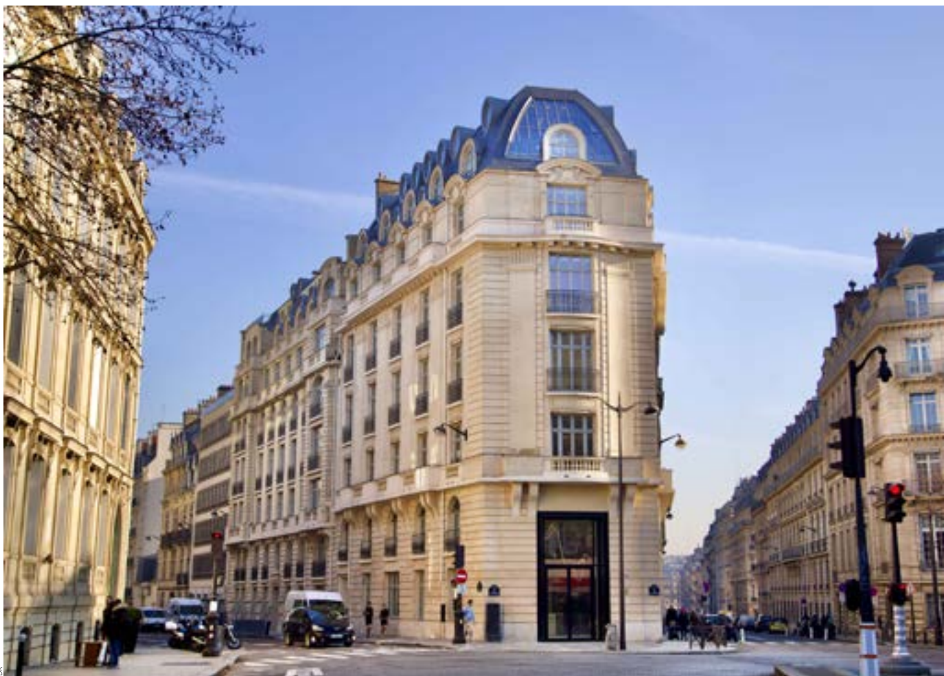
> Le 2, place de Rio de Janeiro (8 ème ), un immeuble « prime » de 8 676 m 2 de bureaux...
